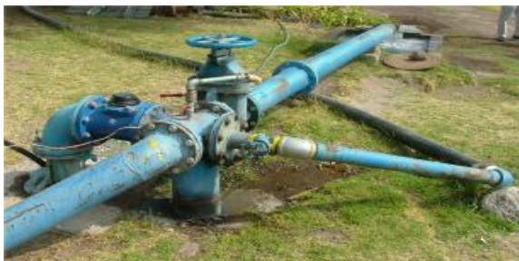
Fotografía 2. Típico caso de restricción de espacio para colocación de medidor.
