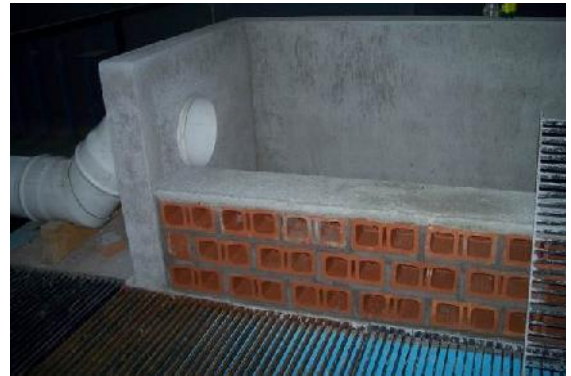
Fotografía 4. Configuración al término del tramo recto de tubería y tanque amortiguador.
